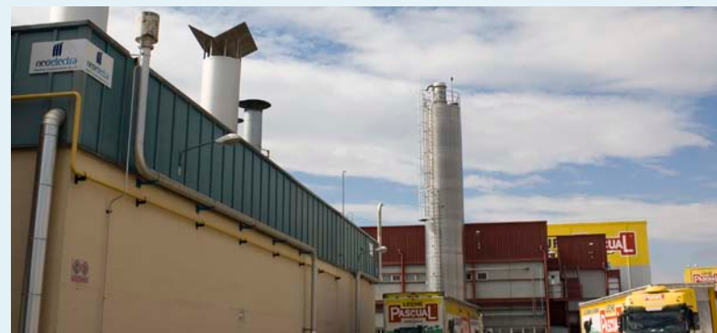
Instalaciones de cogeneración en el complejo de Aranda de Duero.
